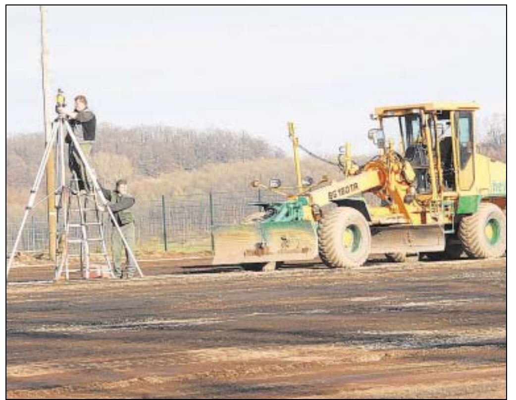
Die Bauarbeiten sind auf dem „Holloh“ in vollem Gange. Jeder, der bei dem Wettbewerb abnimmt, spült 25 Euro in die Kasse der SG Balve/Garbeck. Foto: Stefan Scherer
